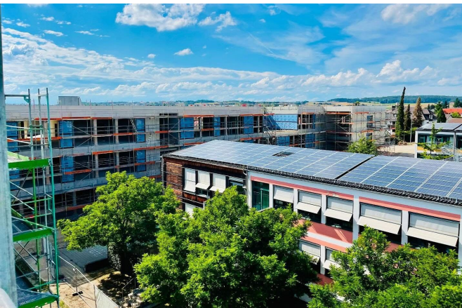
Blick von der Schulbaustelle auf das Sonderpädagogische Förderzentrum des Landkreises
